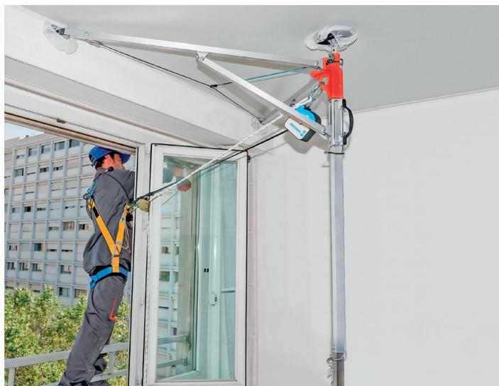
**Seguridad T-A. Punto de anclaje y línea de vida:** El operario/s colocara una placa/s en la zona mas segura de la fachada; una vez retirada, le quedara un agujero/s con un tornillo para ser utilizado en posteriores intervenciones también, y proporcionándonos siempre un anclaje seguro.
