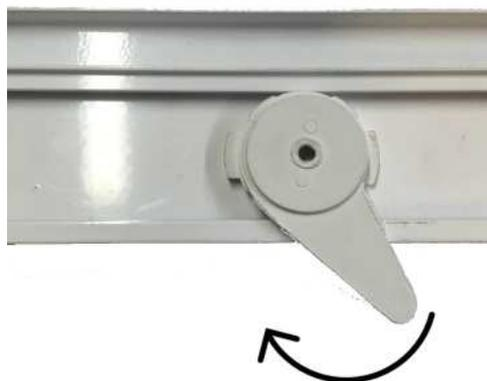
Vista desde arriba colocación del riel cuando los soportes ya están fijados en el techo y dirección de giro posterior.
