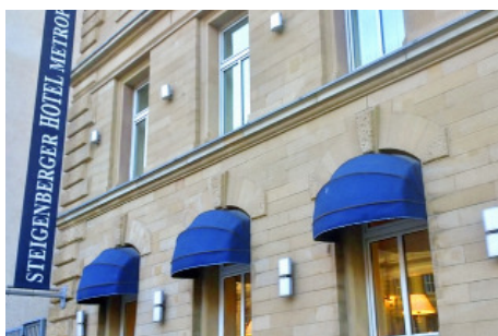
Ejemplos CAPOTA H. Capota hierro, opción de fabricación solo fija. Radio de la curva estándar de 25 cm de sección, perfil 20x20x1.5 mm. Diseño DCP001
